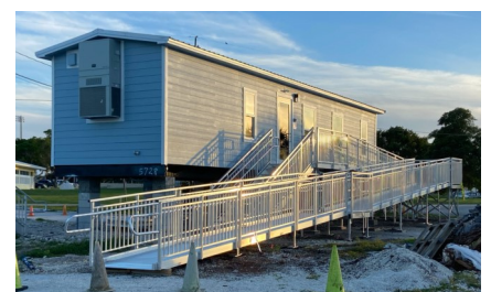
Actual modular now in place
